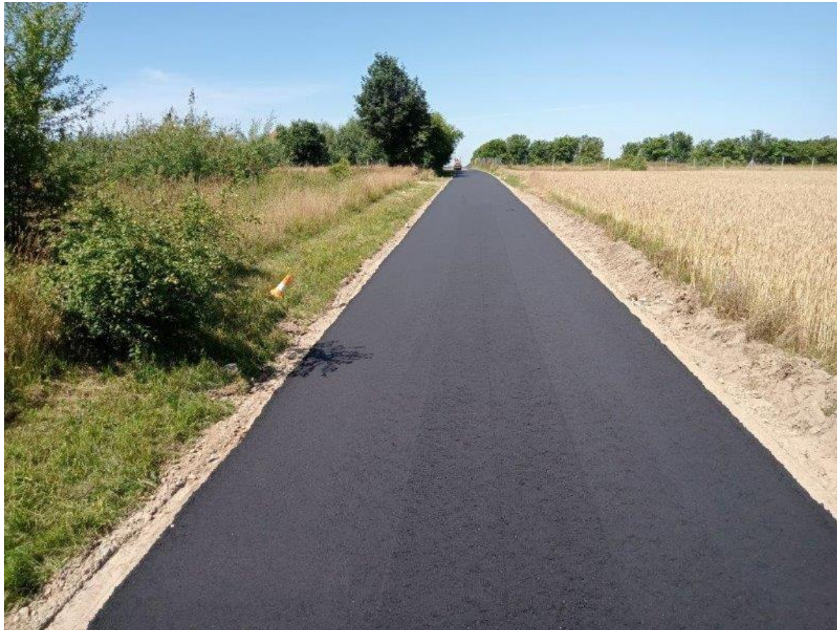
Budowa drogi we Włynkowie w kierunku Mon-Cherry
