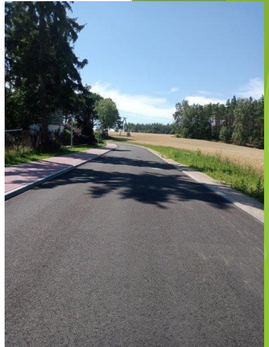
Budowa drogi we Wrześciu
