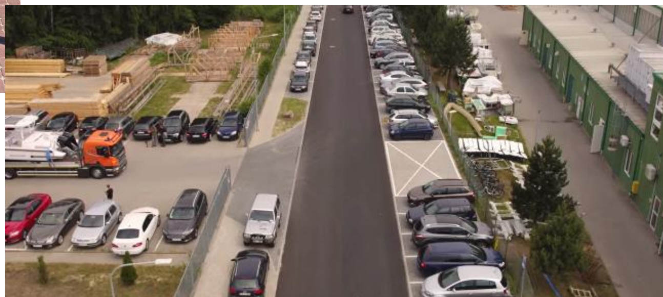
Budowa ulicy Przemysłowej w Głobinie
